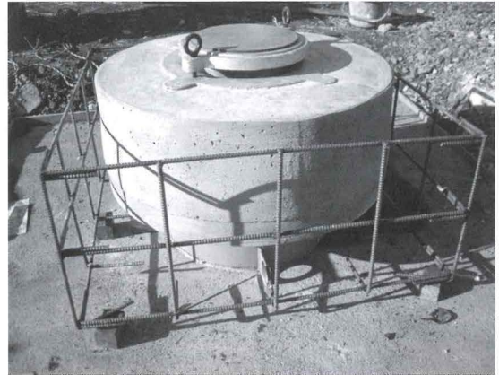
① 「BSLパイル」施工完了状況
