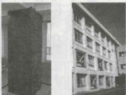
工法は炭素繊維補強 トグル制震構法
